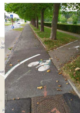
Exemple d'aménagement cyclable rue de Rennes
